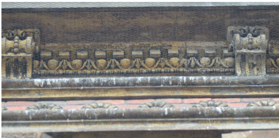
Fot. nr 7. Zachowane pozostałości powłok malarskich na detalach sztukatorskich.
