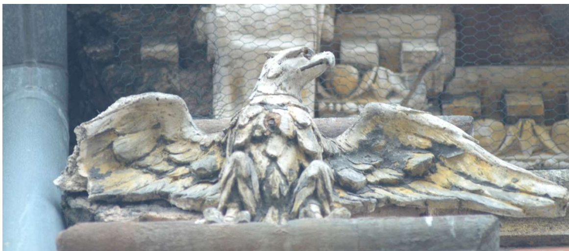
Fot. nr 6. Zachowane pozostałości powłok malarskich na detalach sztukatorskich.
