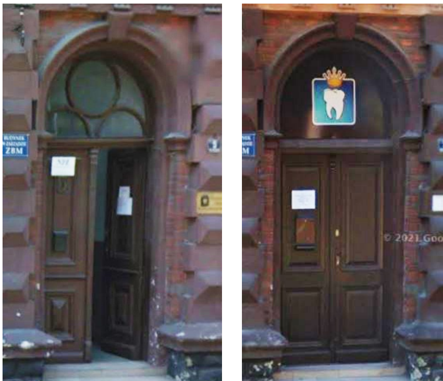
Fot. nr 9 i 10. Widok drzwi w 2013 oraz w 2017 roku. Widoczne uproszczenie formy nowych drzwi, polegające na rezygnacji z wypełnienia dolnej płyciny, rezygnacji z listwy środkowej na drzwiach, zmiany profilu ślemiona oraz rezygnacji z detalu nadślemienia.
