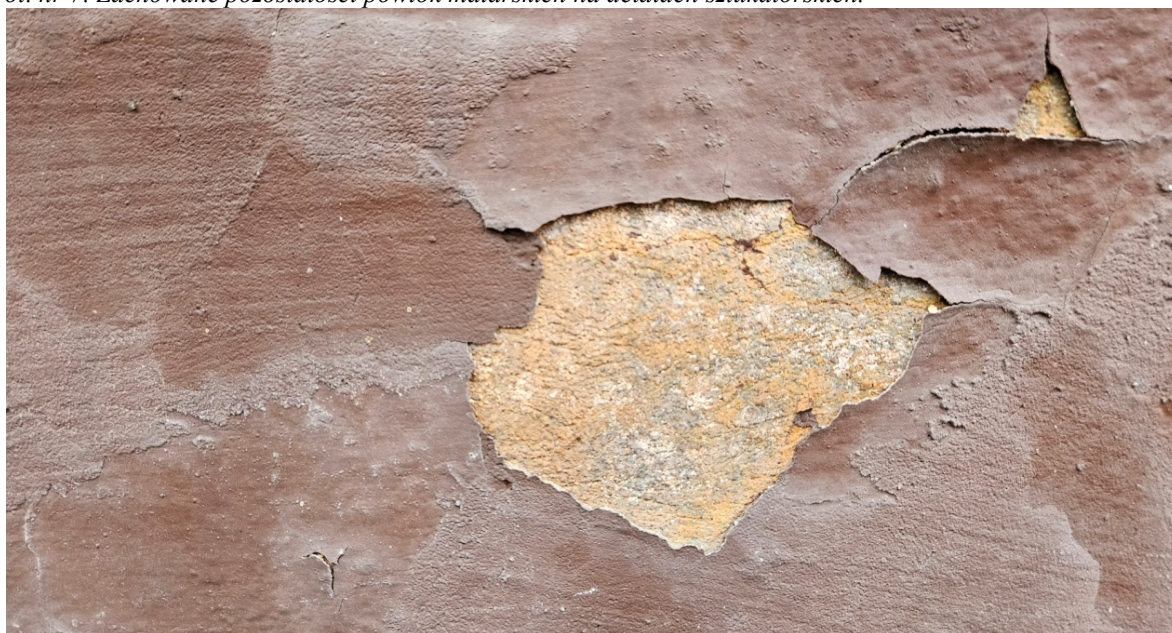
Fot. nr 8. Zachowane pozostałości powłok malarskich na boniowaniu parteru.
